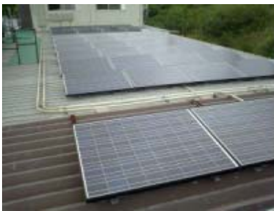
「太陽光発電システム」
